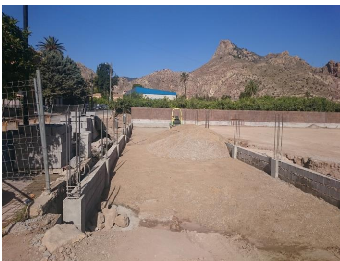
Imagen. Arranque de pilares, murete de bloque de cierre y relleno de gravín.
