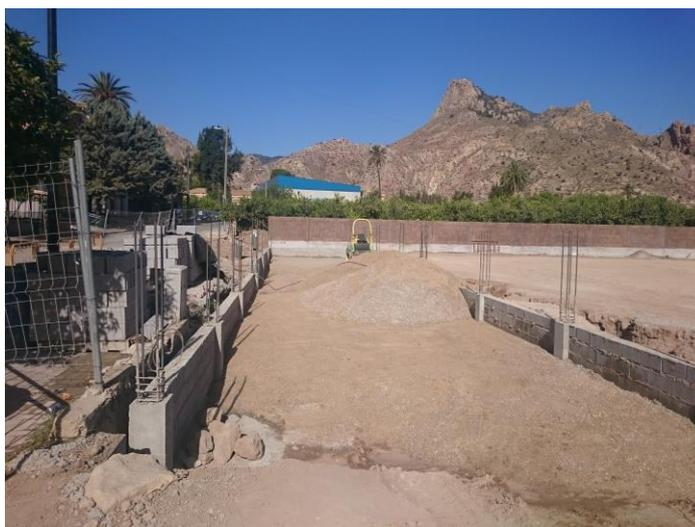
Imagen. Arranque de pilares, murete de bloque de cierre y relleno de gravín.
