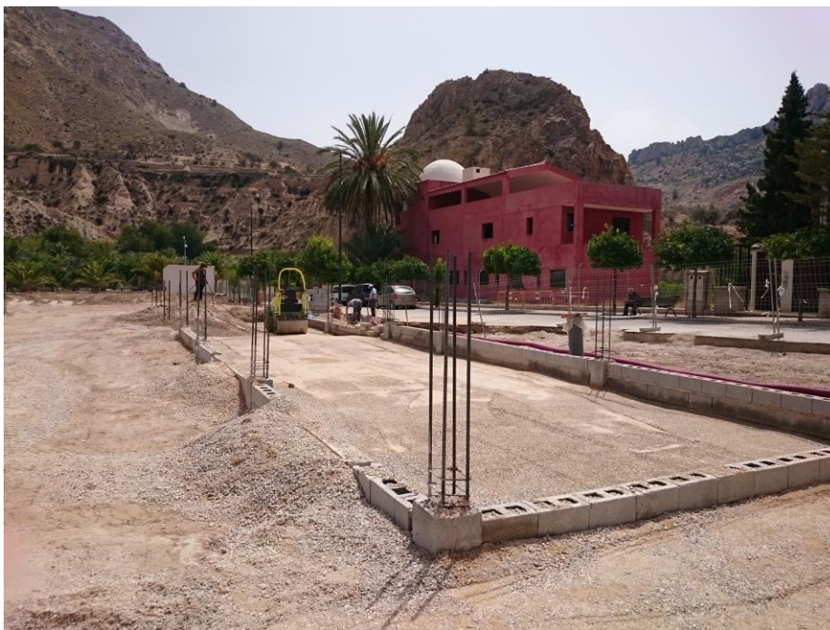
Imagen 1. Estado actual: cimentación y arranque de pilares preparados.
