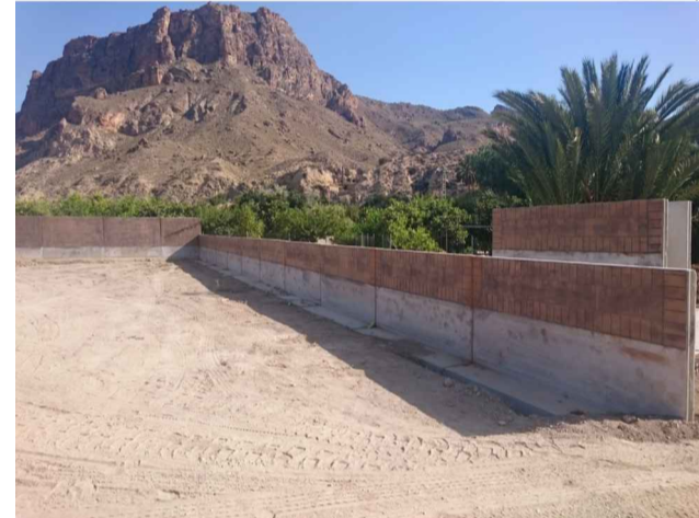
MURO DE CERRAMIENTO DE INSTALACIONES
